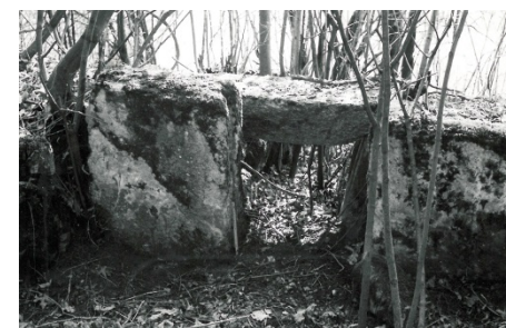
Beispiele steinerner Schwellstöcke mit seitlich eingehauener Nute zum Einlassen des Schwellbrettes
