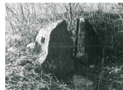
Beispiele steinerner Schwellstöcke mit seitlich eingehauener Nute zum Einlassen des Schwellbrettes
