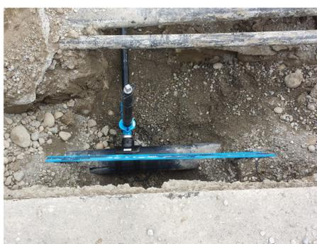
Leitungsbau im Strassenbereich mit Hausanschlussschieber
