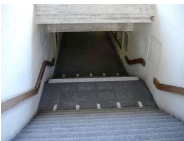
Die steilen Treppen sind für Rollstuhlfahrer ein unüberwindbares Hindernis.
