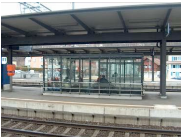
verglaste Wartehäuschen geben den Benutzern Sicherheit (soziale Kontrolle)
