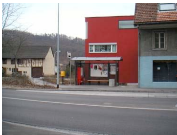
mit Witterungsschutz, Sitzgelegenheit und Billettautomat gut ausgerüstete Haltestelle
