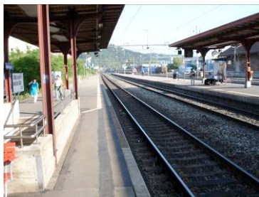
Der Wartebereich neben dem Treppenaufgang ist sehr schmal. Die weisse Sicherheitslinie ist darum unterbrochen.
